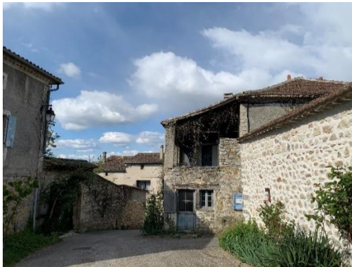
Toiture ancienne, source : IATE
