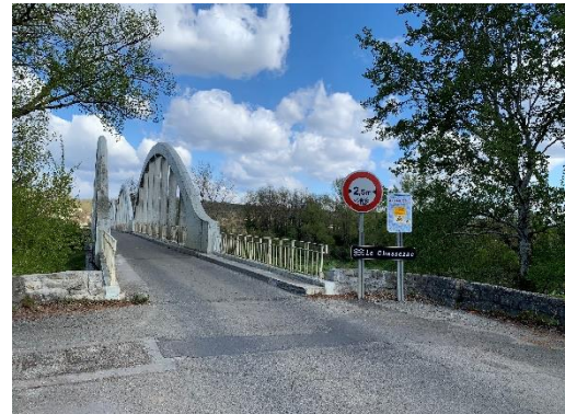
Route départementale RD246, source : IATE
