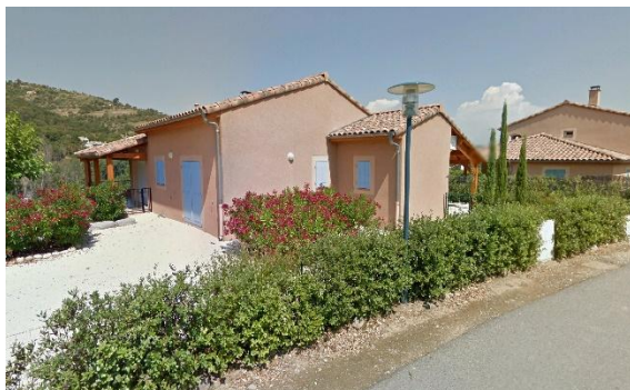
Bâti isolé récent à Vallon-Pont-d'Arc
