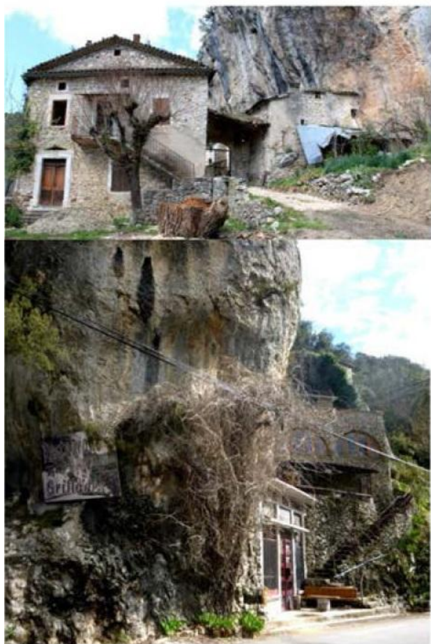
Deux constructions troglodytes du site
