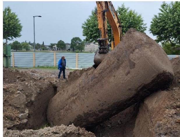
Retrait des cuves d'hydrocarbures
