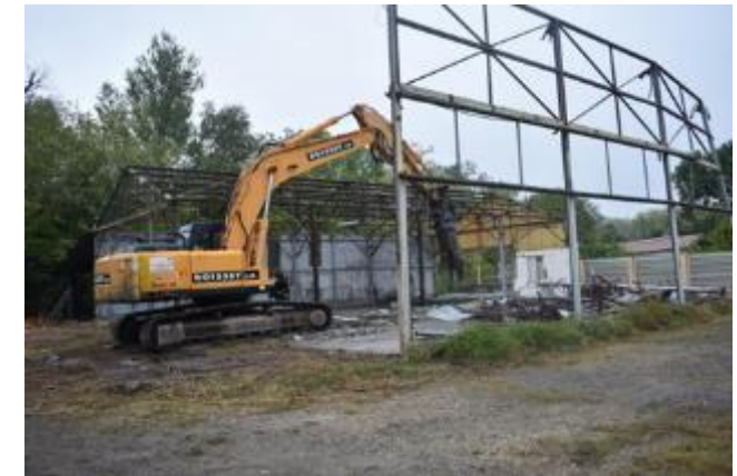
Retrait toiture amiantée et démolition structure
