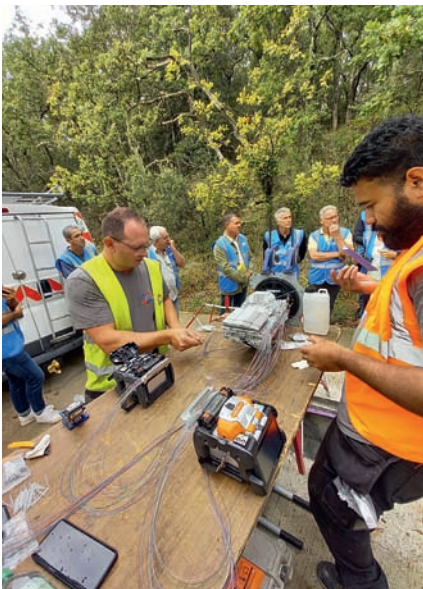
Une visite des travaux de raccordement à Ruoms.
